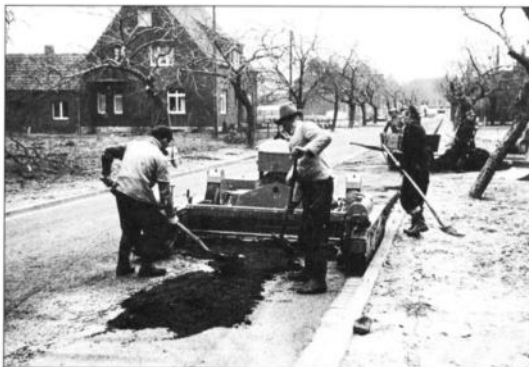
Die Teermaschine an der Ostfelder Straße im Einsatz
